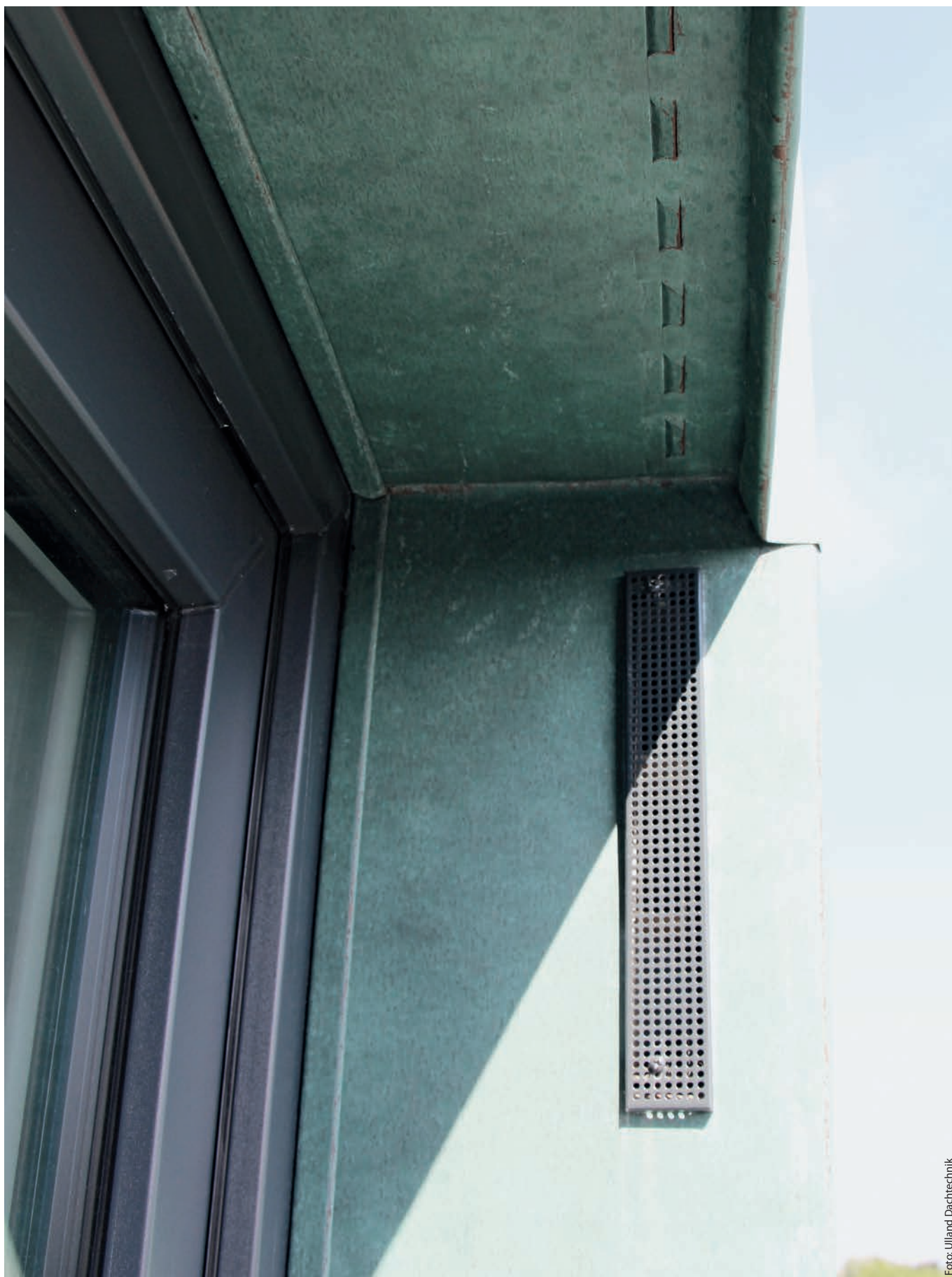
Wohnraumlüfter mit schmalen rechteckigen Lüftungsgittern mussten zum Teil in die Fensterlaibungen integriert ...
