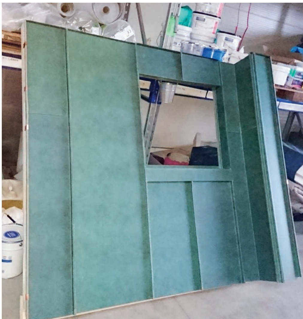
Um die architektonischen Wünsche zu erfüllen und Details einheitlich, fachgerecht und wirtschaftlich zu erstellen, wurden Fassadenmuster in der Größe 1:1 angefertigt.
